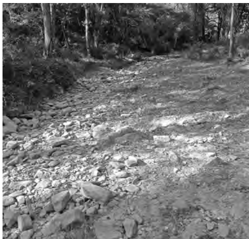
Estat actual de la riera (fot. Plataforma)
