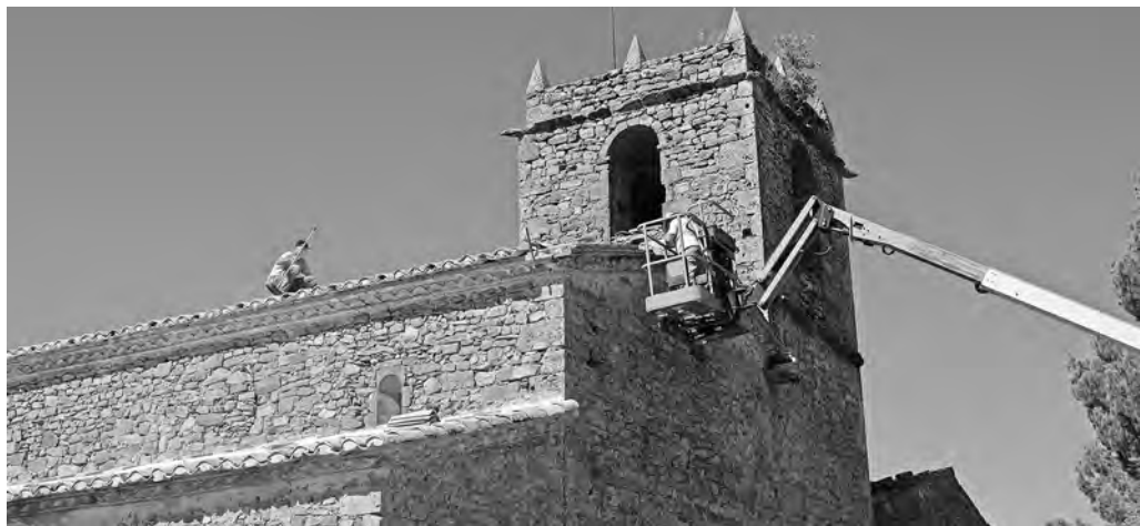
Treballant a la teulada de Sant Joan d'Oló (fot. J. Canamasas)
