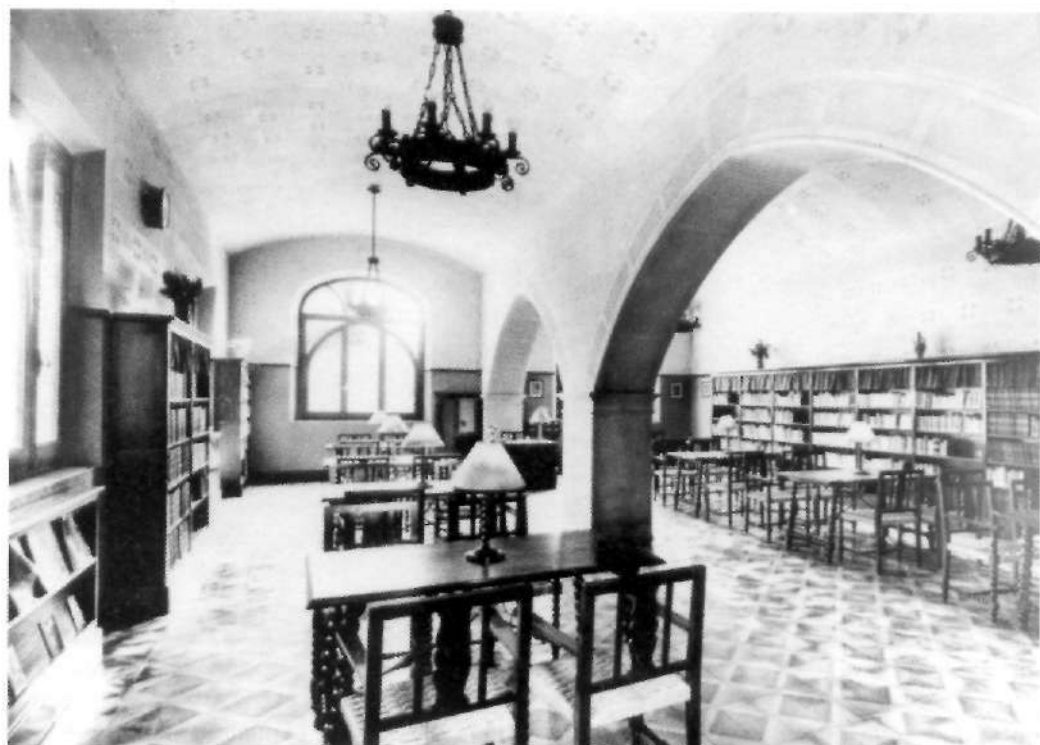
Interior de la biblioteca (any 1935)
