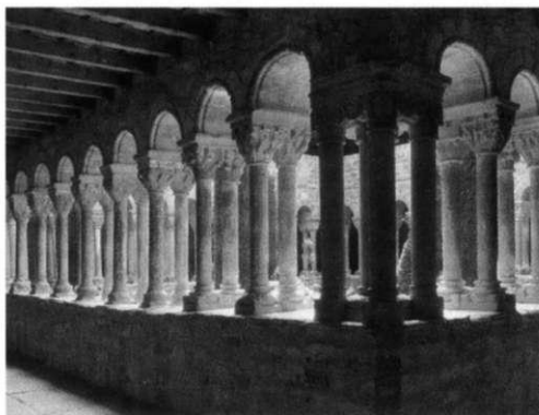
Vista general de les ales sud i est del claustre
