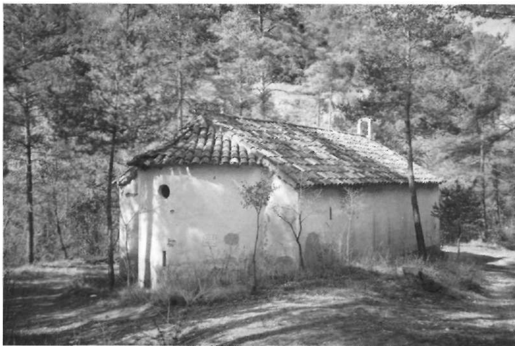
Capella de la Mare de Déu de la Tosca (pel darrere)
