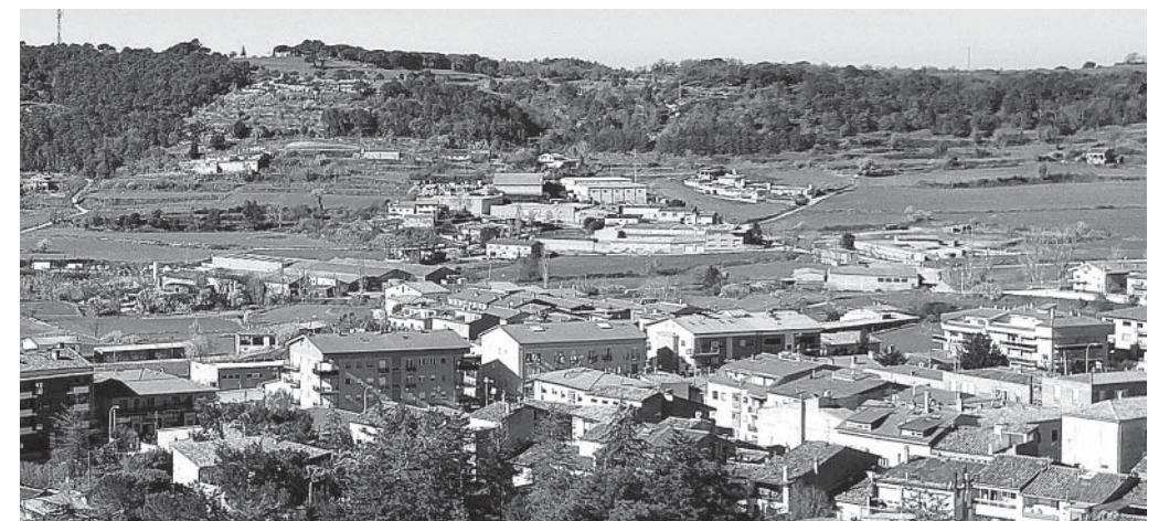
Zona industrial del Sot d'Aluies (fot. C.I.C. – Moià)
