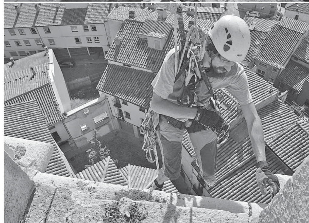
Neteja de la part superior i de les façanes del campanar (fot. Elisa Roca i J. Font)
