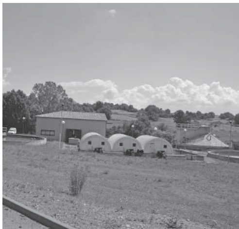
Depuradora de Moià (fot. J. Font)
