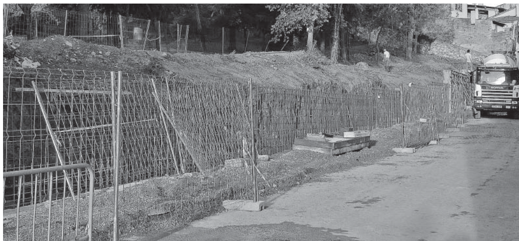
Reforma del mur del parc al carrer de Santa Magdalena, l'octubre passat (fot. C.I.C. - Moià)
