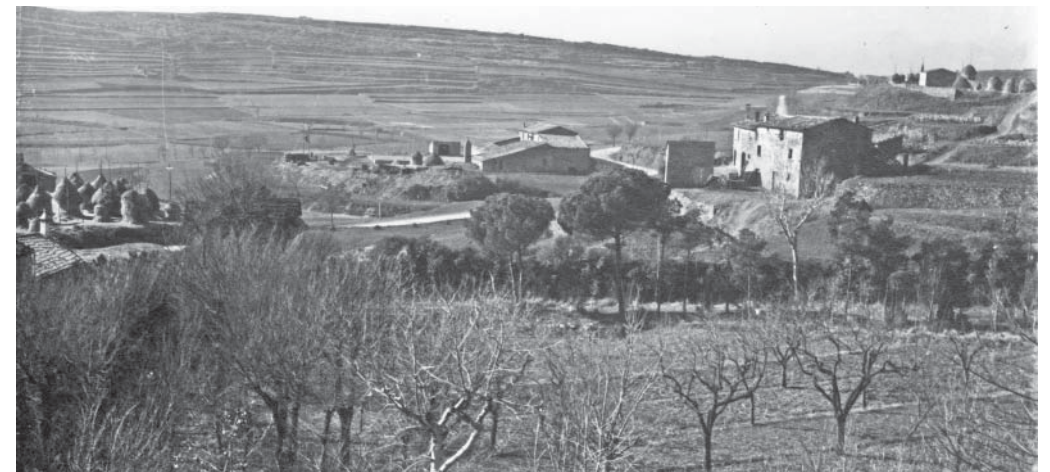
Eres del Sastre, de Cal Teixidor i d'en Fermí, cap a 1930 (fot. J. Renom; col·l. M. Alsina)
