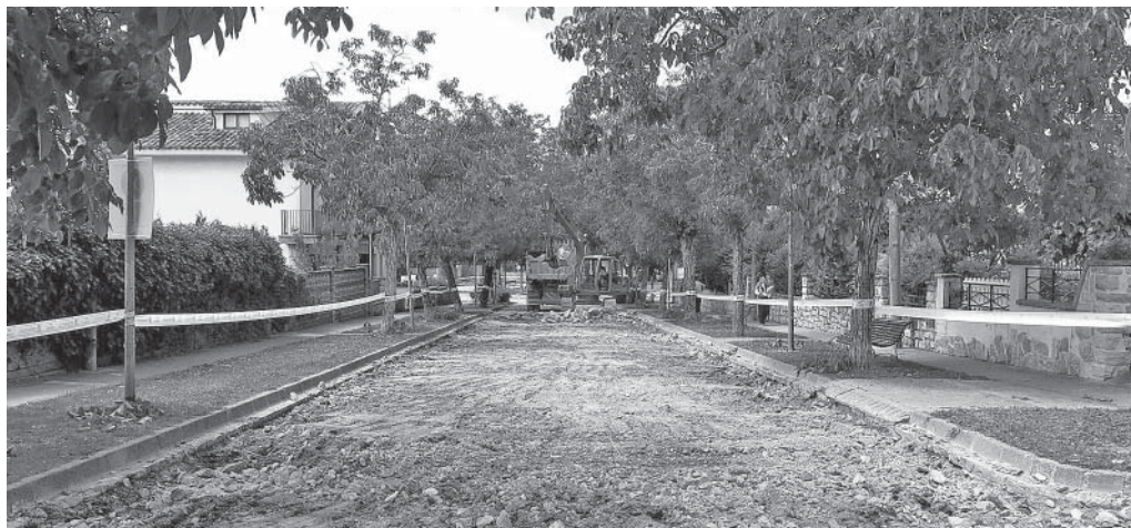
El carrer de l'Onze de Setembre en obres (fot. C.I.C. - Moià)
