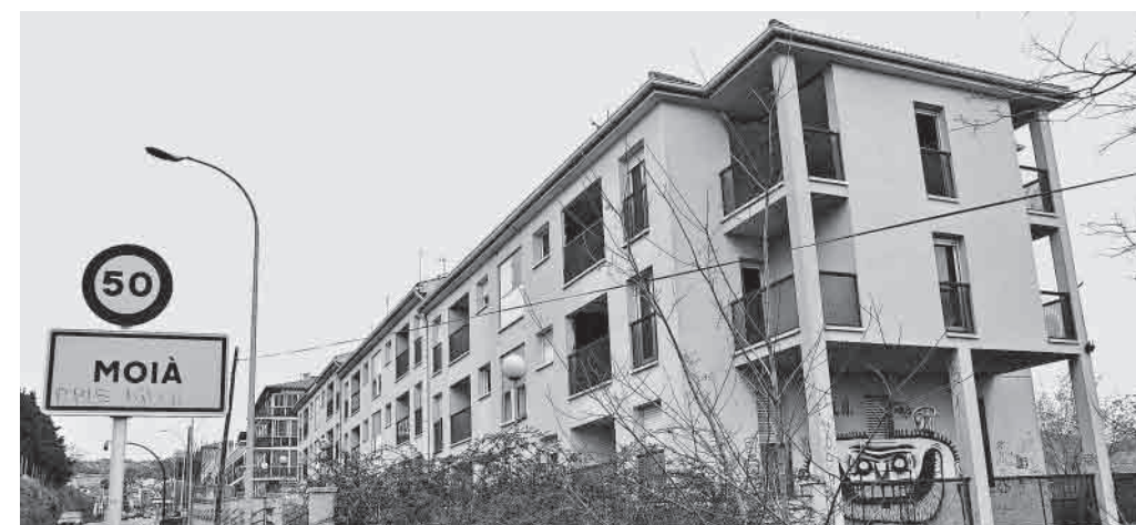
L'antiga caserna de la Guàrdia Civil (fot. A. Lozano)
