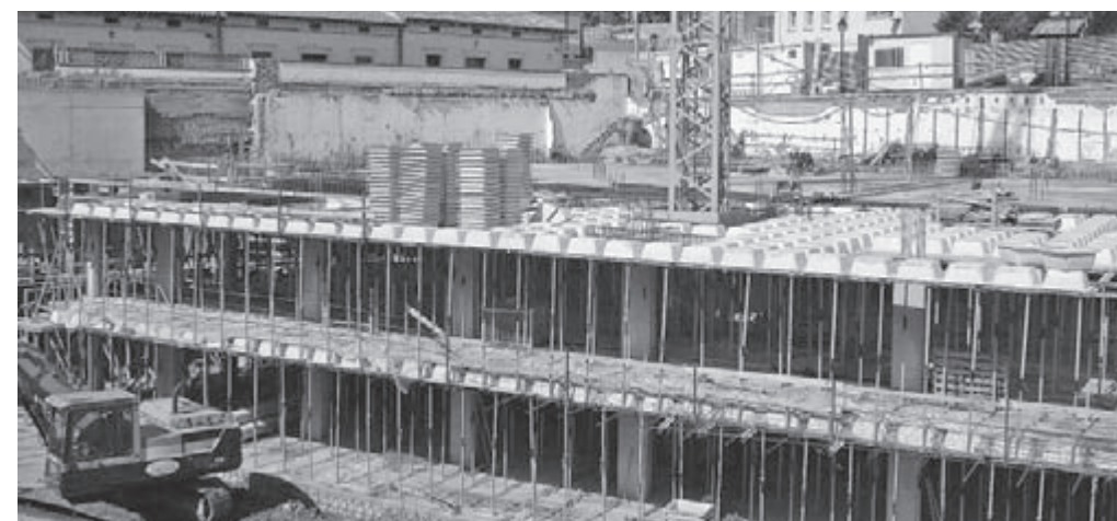
El pàrquing del CAP en construcció, l'any 2008 (fot. J. Clarà)
