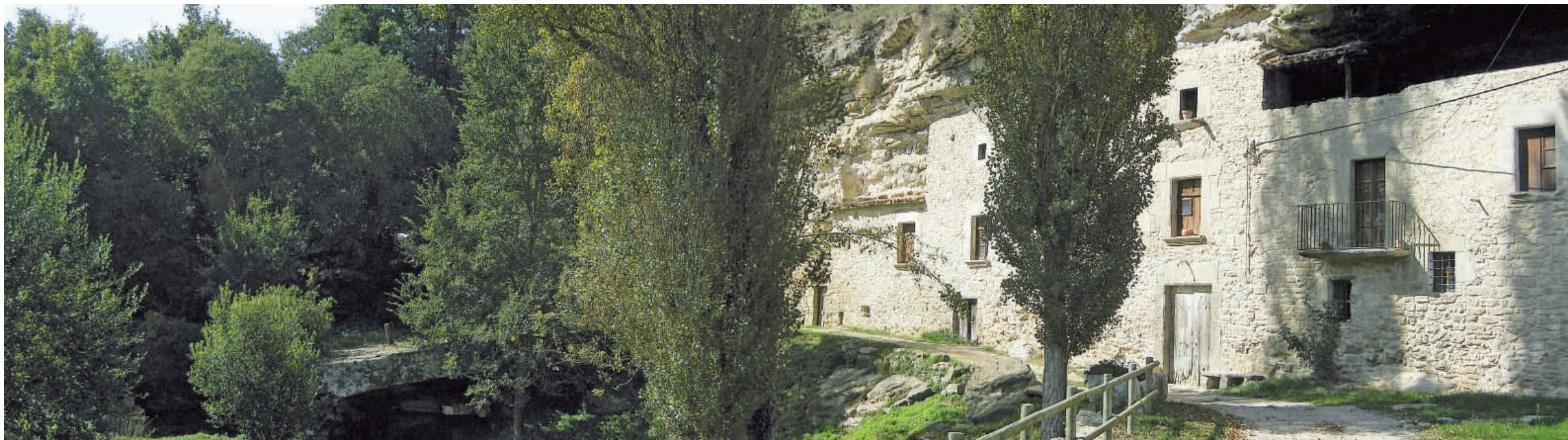
Esplugues (Castellcir), seu d'un radial de l'Ecomuseu del Moianès (fot. Consorci del Moianès)
