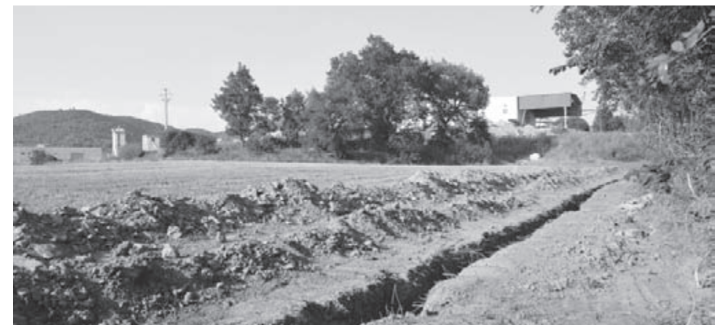
Obres del clavegueram del polígon del Pla-romaní (fot. J. Font)
